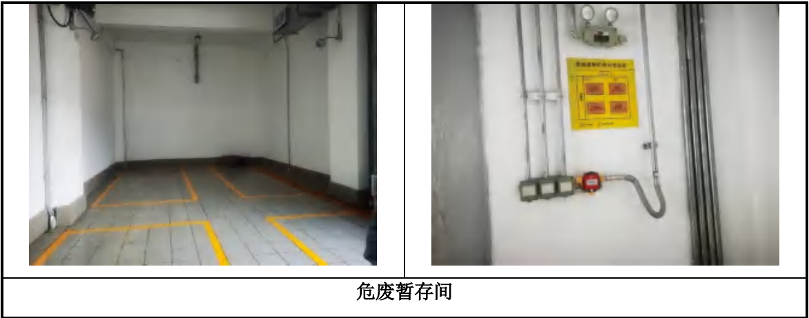
图 4.1-2 固废暂存措施情况图
