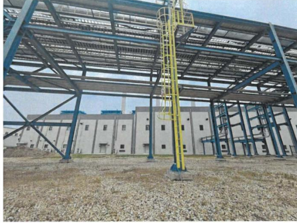
项目现场照片
