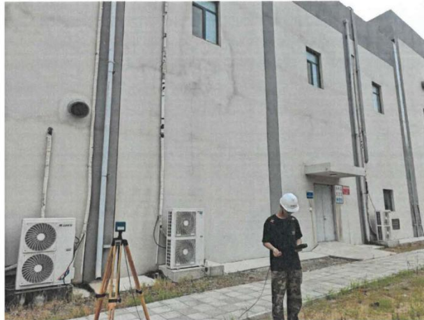
现场检测照片
